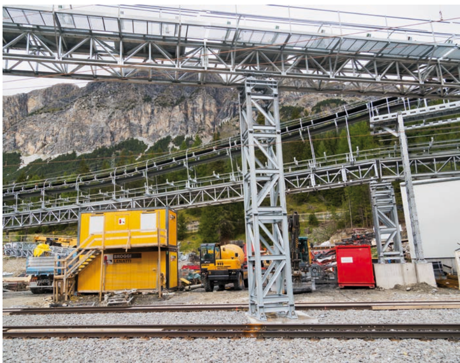
La roche est transportée par des convoyeurs.
