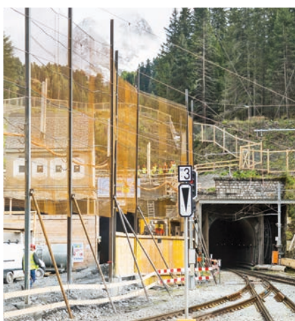
Construction du nouveau tunnel
